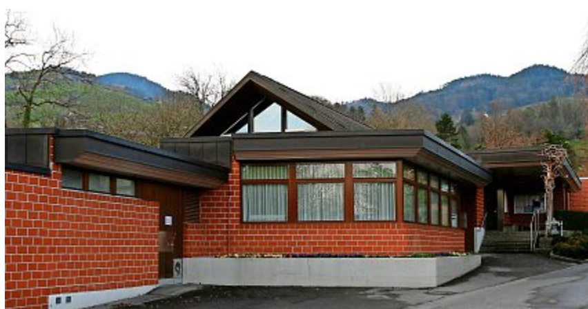
Das Hallenbad ist noch bis am 24. Februar geöffnet. Anschliessend beginnen die Abbrucharbeiten. Archiv
